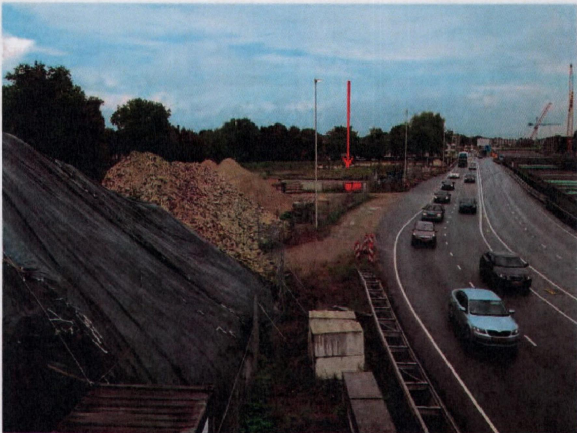
Ligging besluitgebied (ter hoogte van de pijl) langs de A2-traverse
